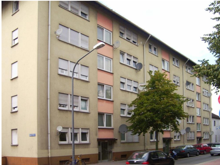
Abbildung 8: Deutsche Straße 19-23 als Beispiel für "mittleren Sanierungsbedarf"
