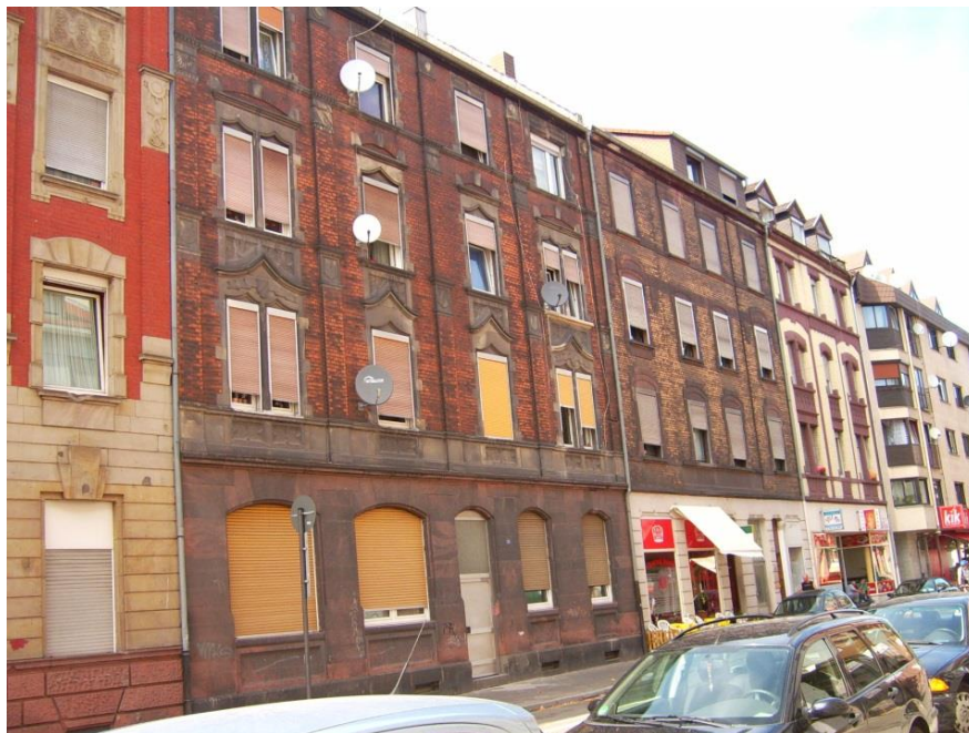
Abbildung 9: Valentin-Bauer-Straße 28 als Beispiel für "hohen Sanierungsbedarf"
