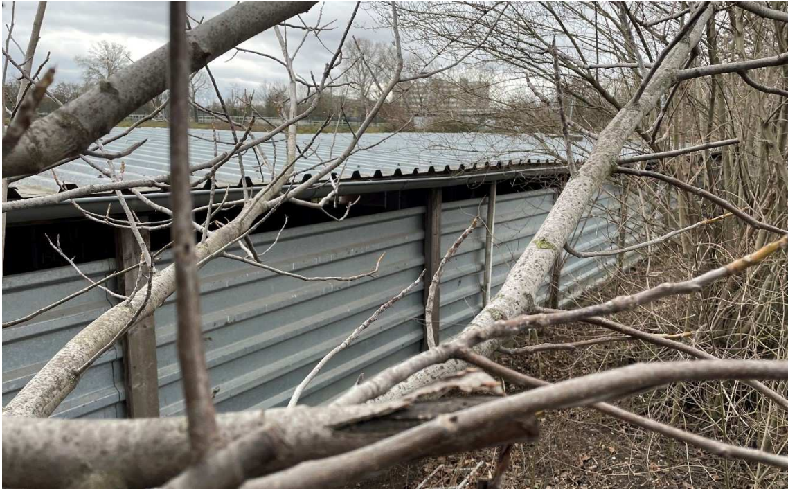
Bild 5: Dacheindeckung des Pferdestalls mit Trapezblecheindeckung
