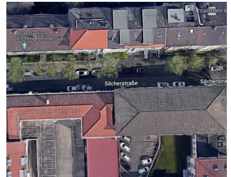
Luftbild Bestandsdach (Walmdach) Finanzamt
