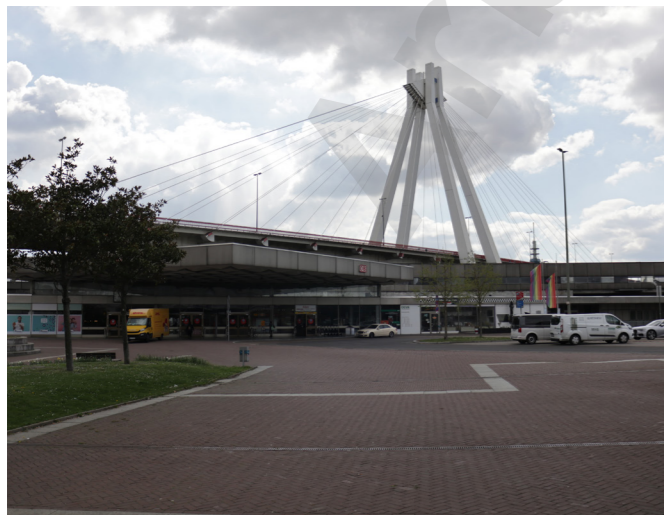
Blick auf die Kurt-Schumacher-Brücke
