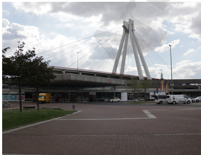
Blick auf die Kurt-Schumacher-Brücke
