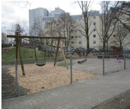
Zustand mittel (KSP Fröbelstraße):
