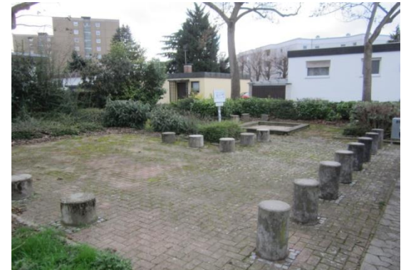
Zustand schlecht (Pfingstweide, Bukarester Straße)
