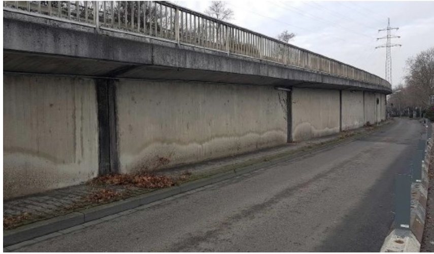
Ansicht von Osten; „luftseitig“
