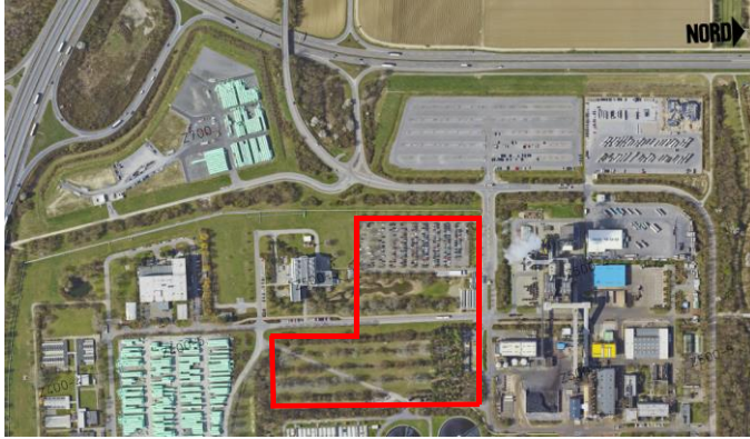
Hochstraßenabriss: Maßnahmen an Kläranlage
