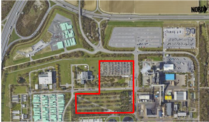
Hochstraßenabriss: Maßnahmen an Kläranlage
