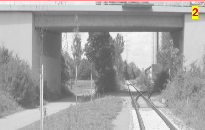
Unterführung L523, Versetzen der BASF-Gleisanlage und eines Wirtschaftsweges
