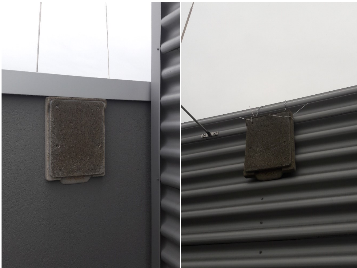
Abbildung 4 Bereits umgesetzte CEF 1 Maßnahme am bestehenden Gebäudekomplex im Jahr 2019.
