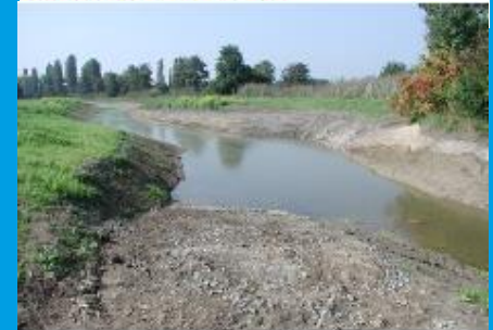
Bauabschnitt 1, Sommer 2014 (Foto: Stadt Ludwigshafen, Bereich Umwelt)
