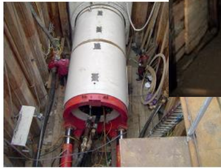
Unterirdischer Rohrvortrieb in Oggersheim
