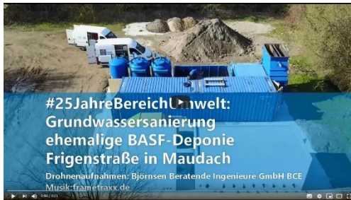
#25JahreBereichUmwelt: Grundwassersanierung ehemalige BASF-Deponie Frigenstraße
