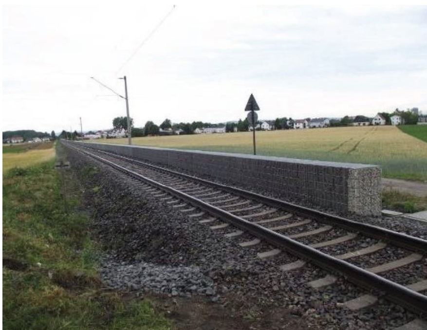
Abbildung 11: Niedrige Lärmschutzwand (Lärmschutzgabionen) Zufahrt KVT
