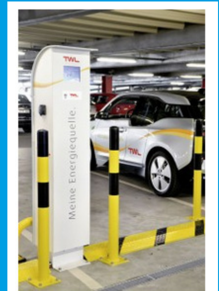
An den Ladesäulen im Parkhaus Walzmühle in Ludwigshafen können jeweils drei E-Autos Strom tanken.
