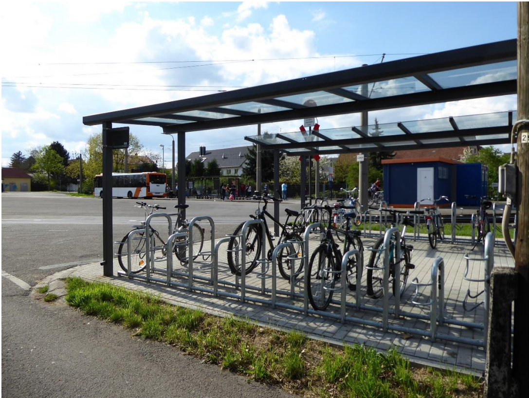
Abbildung 30: Überdachte Fahrradabstellanlage Endstelle Rheingönheim
