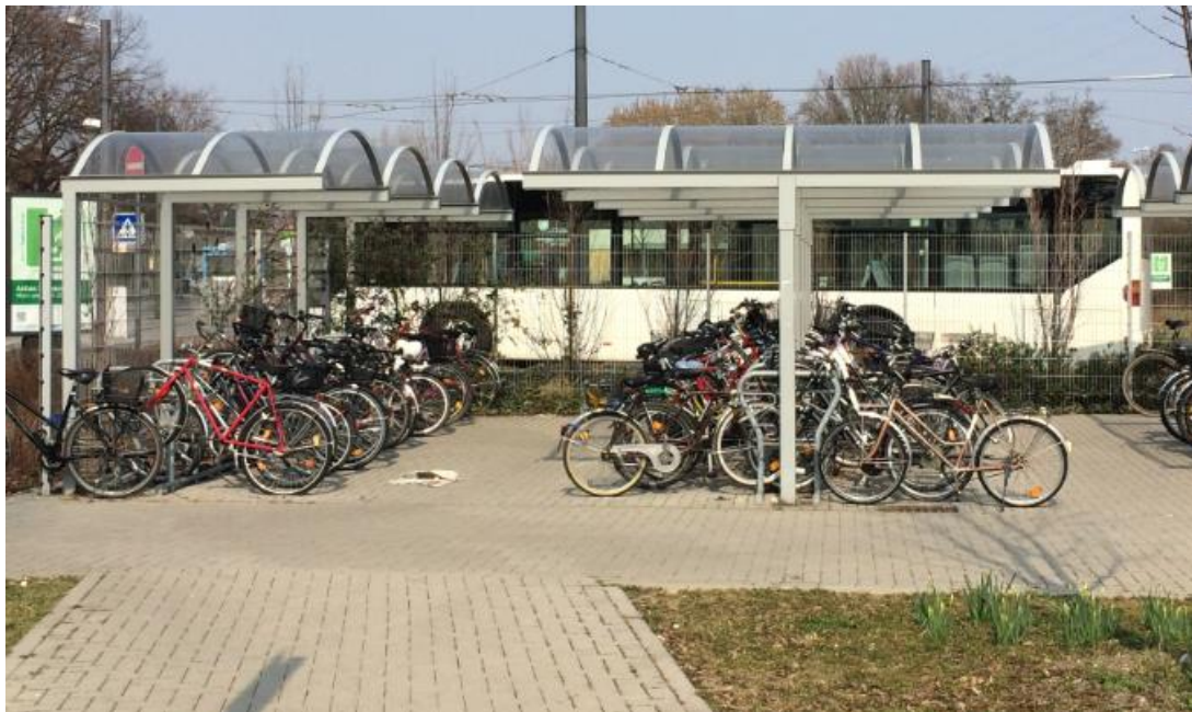
Abbildung 32: Überdachte Fahrradabstellanlage gegenüber der Bus- und Bahnsteige
