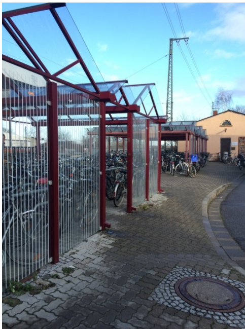
Abbildung 25: B+R-Anlage am Bahnhof Schifferstadt
