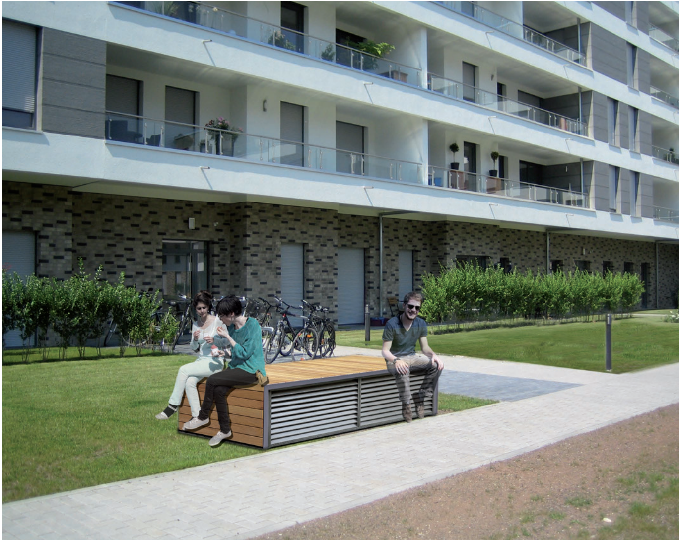
Lüftungsbauwerk | Individuelle Holzkonstruktion
