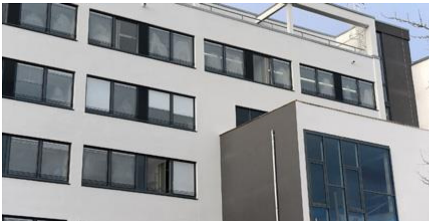
Energetisch sanierte Fassade der Stadtbibliothek
