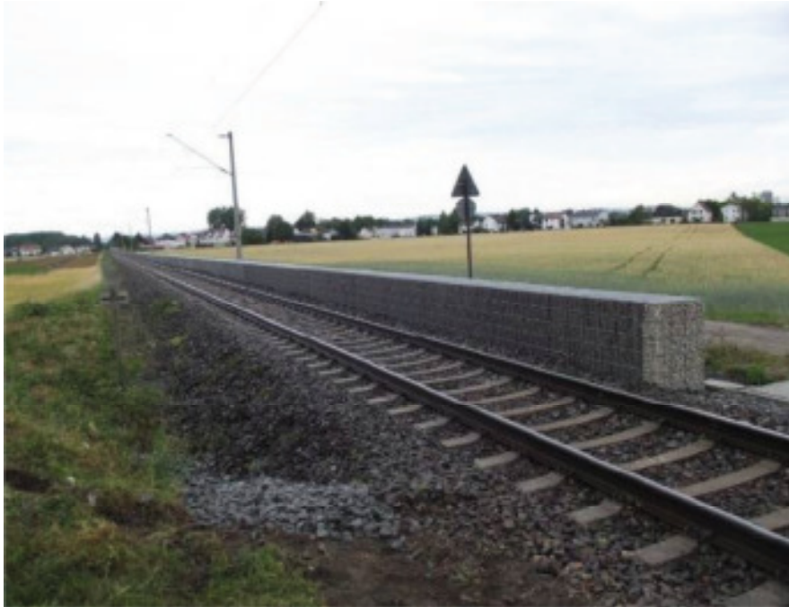
Abbildung 15: Niedrige Lärmschutzwand (Lärmschutzgabionen) Zufahrt KVT
