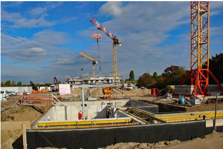
Abbildung 33: Projekt der GAG: Geförderter Wohnraum an der A.-Diesterweg-Straße in Oggersheim.
