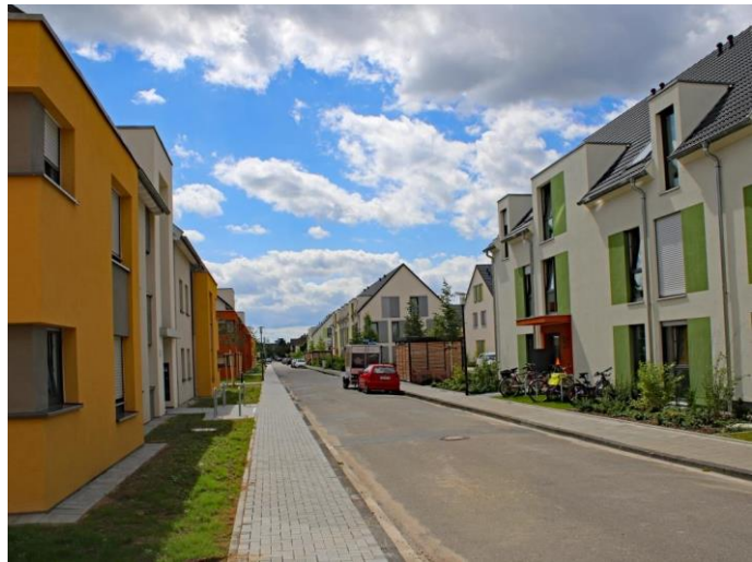
Abbildung 22: Abriss und Neubau im Ligustergang, Gartenstadt.
