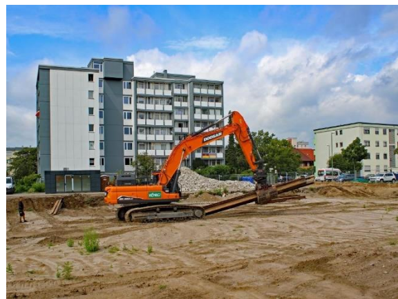
Abbildung 30: Gründungsarbeiten für einen Wohnhausneubau in Oggersheim, A.-Diesterweg-Straße.
