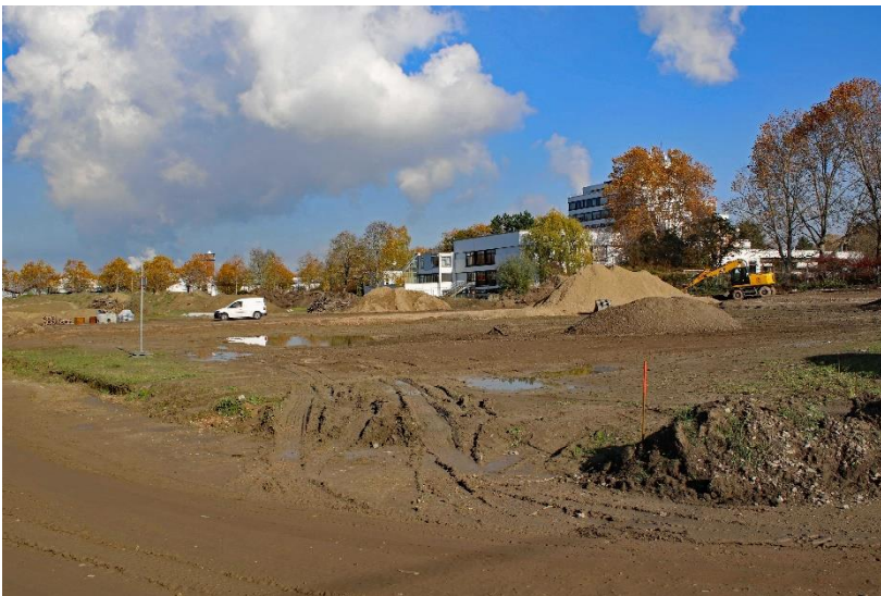
Abbildung 34: Die Erschließungsarbeiten für die Heinrich-Pesch-Siedlung haben begonnen.
