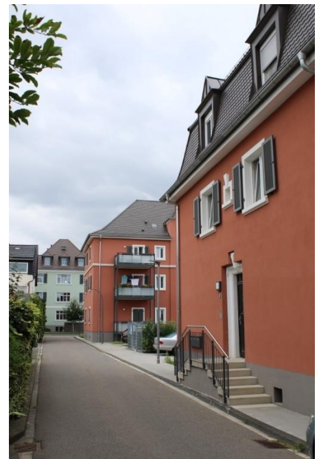
Abbildung 8: Modernisierung der GAG, „Finkennest“ in Friesenheim.
