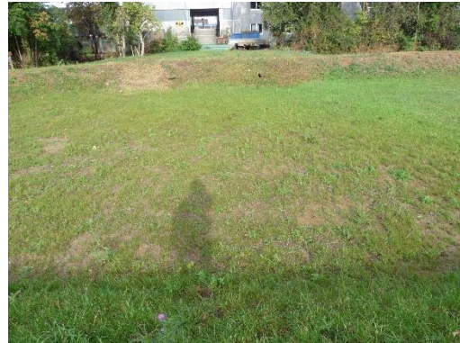
Versickerungsmulde – Vegetationsfläche Blick von Südosten
