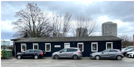
Bestehendes Bürogebäude – Blick von Nordwesten (Quelle: Büro Olschewski)
