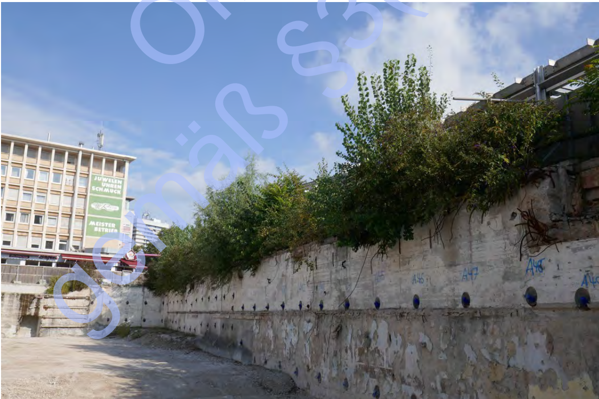
Abb.2: Spontaner Gehölzaufwuchs oberhalb der Ostseite der Baugrube
