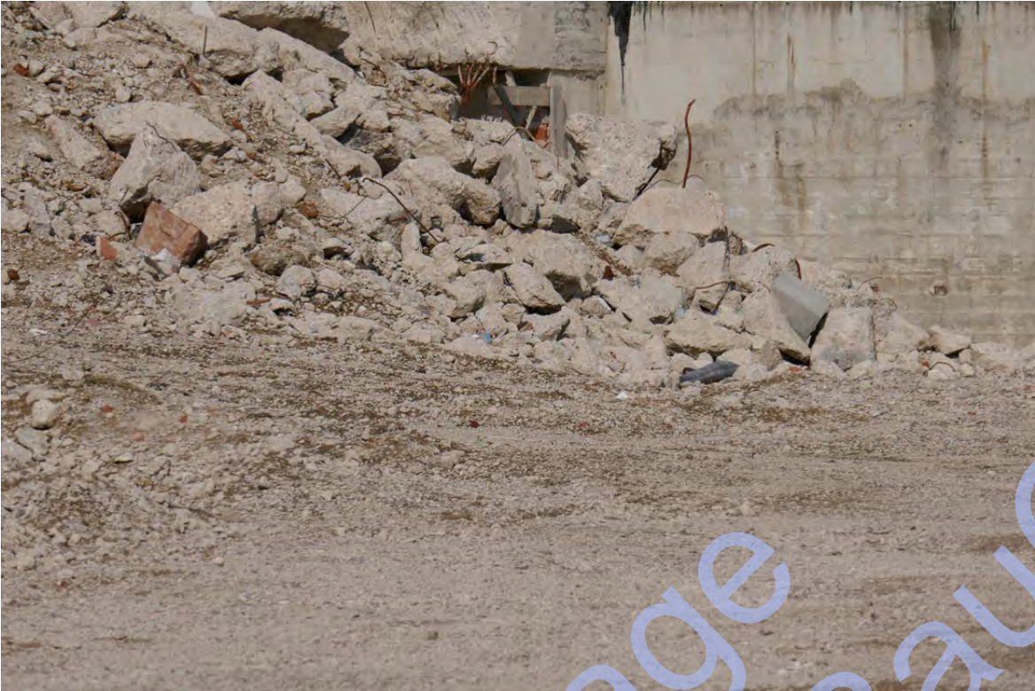
Abb.3: Teilaspekt der Bodenoberfläche der Baugrube mit großer Aufschüttung aus grobem Abrissmaterial
