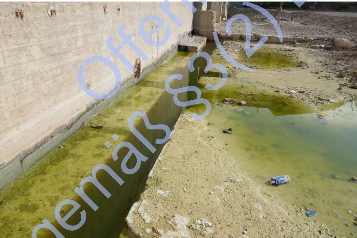
Abb. 4: Temporäre Wasserstellen im nördlichen Bereich der Baugrube
