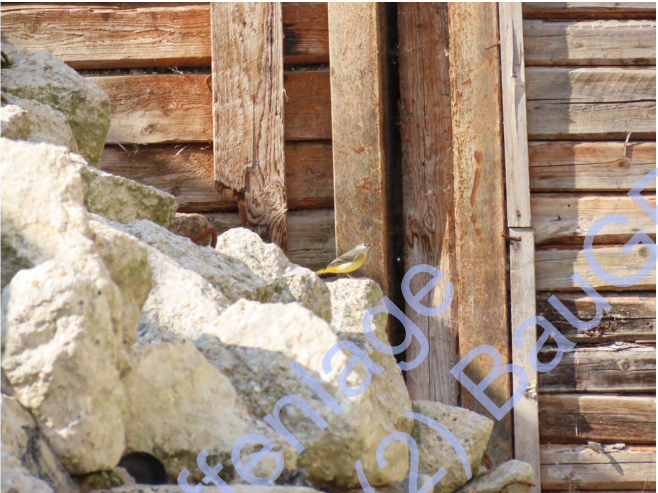
Abb. 7: Schafstelze innerhalb der Baugrube (am 13. September)
