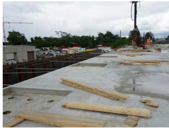
Baustelle in der Endphase (Foto: SGD Süd)
