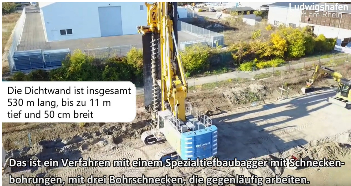
Screenshot aus dem Video zur Grundwassersanierung Frigenstraße
