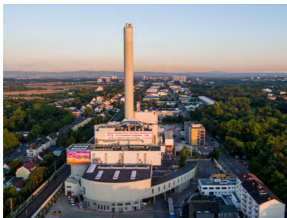
Müllheizkraftwerk der GML aus der Luft (Foto: GML, M. Schepers)
