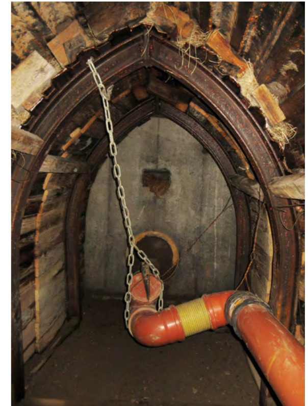
Stollenbau in der Schützenstraße (Foto: Stadt Ludwigshafen, Bereich Stadtentwässerung)
