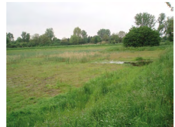
Regenrückhaltebecken Weimarer Straße/Oggersheim Süd (Foto: Stadt Ludwigshafen, Bereich Stadtentwässerung)
