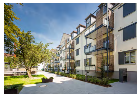
Hohenzollern-Höfe in Friesenheim (Foto: BASF Wohnen + Bauen GmbH, Geisler)
