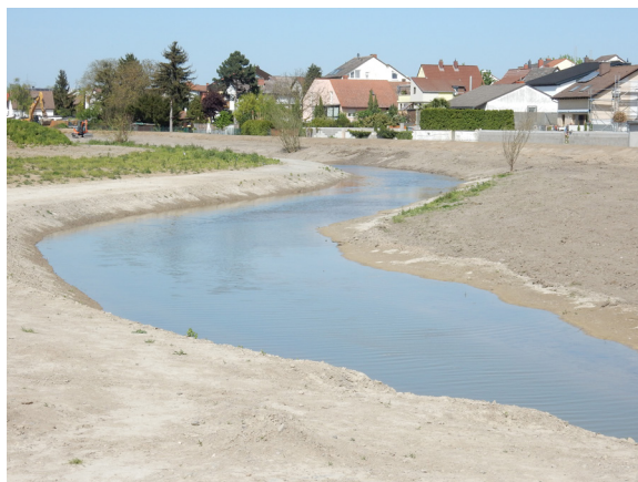
Zweiter Bau-Abschnitt am Altrheingraben (Foto: Stadt Ludwigshafen, Bereich Umwelt)
