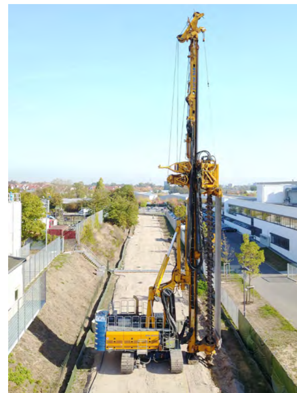
Bohrgerät der Firma Bauer Spezialtiefbau (Fotos: BCE Koblenz)
