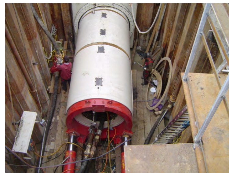
Unterirdischer Rohrvortrieb in Oggersheim (Foto: Stadt Ludwigshafen, Bereich Stadtentwässerung)
