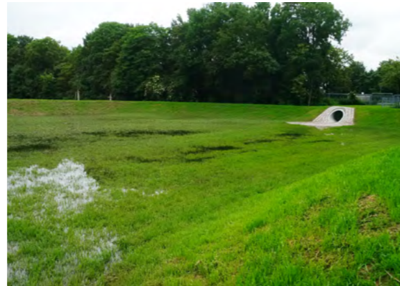
Regenrückhaltebecken Lissaboner Straße (Foto: Stadt Ludwigshafen, Bereich Stadtentwässerung)
