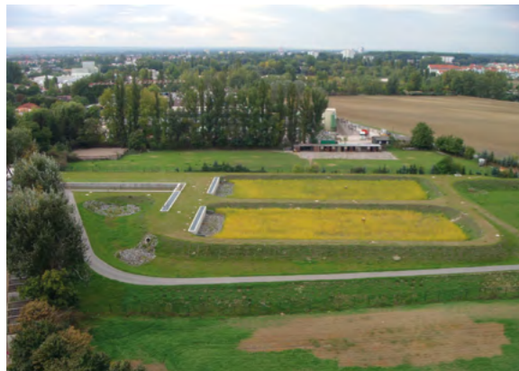
Retentionsbodenfilter Froschlache (Foto: Stadt Ludwigshafen, Bereich Stadtentwässerung)
