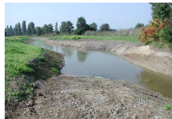
Bauabschnitt 1, Sommer 2014 (Foto: Stadt Ludwigshafen, Bereich Umwelt)
