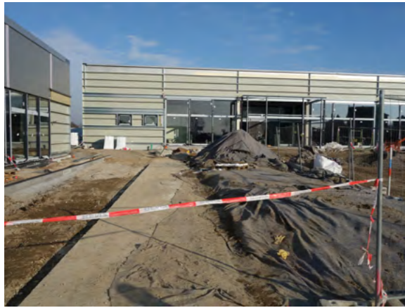
Arbeiten an der Betonplatte (Foto: SGD Süd)
