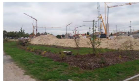
Neubaugebiet „Im Sommerfeld“: Herstellung der Ausgleichsflächen (Foto: Stadt Ludwigshafen, Bereich Umwelt 2016)
