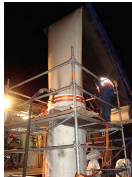
Rohrliningverfahren in Oppau (Foto: Stadt Ludwigshafen, Bereich Stadtentwässerung)
