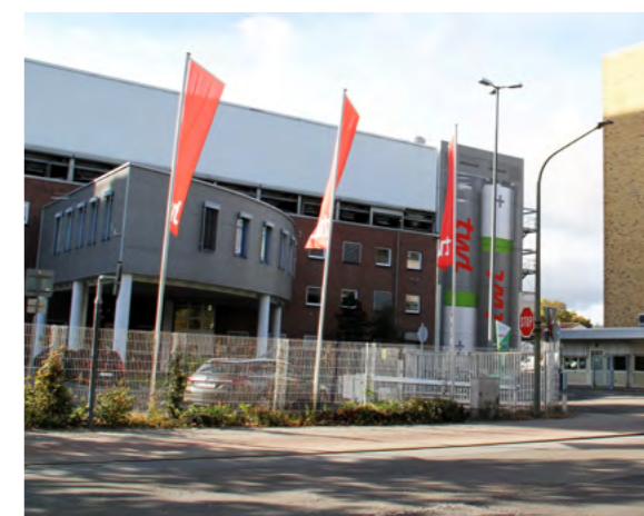
Gebäude TWL mit Batteriespeicher (Foto: TWL)
