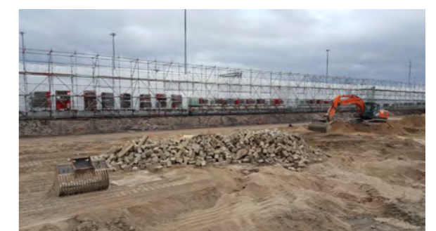
Die Aushubarbeiten wurden regelmäßig durch die Stadt Ludwigshafen überwacht (Fotos: Stadt Ludwigshafen, Bereich Umwelt)
