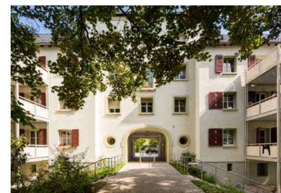
Geibelviertel (Foto: BASF Wohnen + Bauen GmbH, Geisler)
