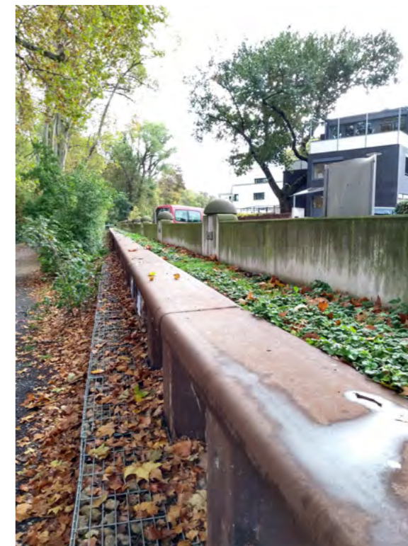
Alte und neue Hochwasserschutzwand am Stadtpark (Foto: Stadt Ludwigshafen, Bereich Umwelt)
