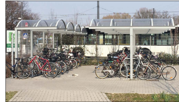
Abbildung 38: Überdachte Fahrradabstellanlage gegenüber den Bus- und Bahnsteigen
