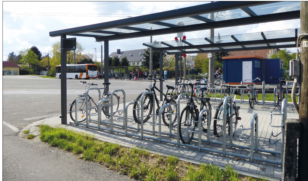
Abbildung 30: Überdachte Fahrradabstellanlage Endstelle Rheingönheim (Quelle: Stadtverwaltung Ludwigshafen)
