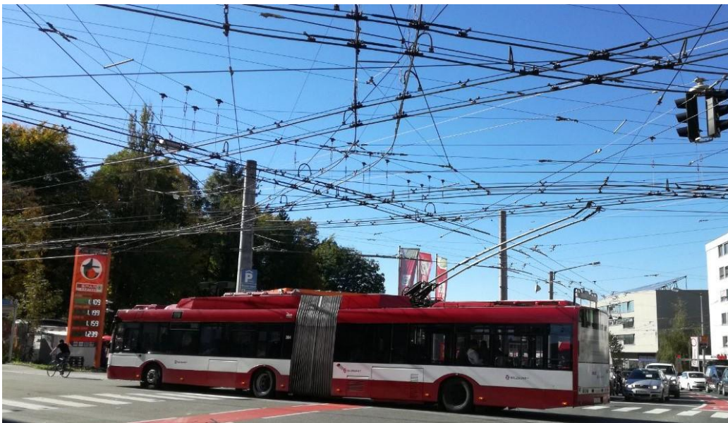
Abbildung 31: Fahrleitungssystem am Knotenpunkt (O-Bus Salzburg) © Julius Rücker
