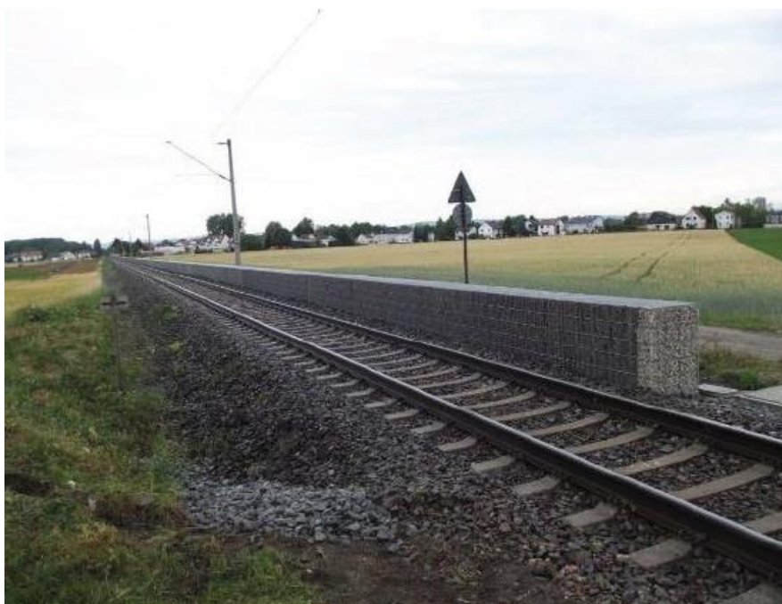
Abbildung 11: Niedrige Lärmschutzwand (Lärmschutzgabionen) Zufahrt KVT
