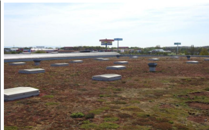
Bild: Extensive Dachbegrünung Metro (Quelle: Stadt Ludwigshafen)
