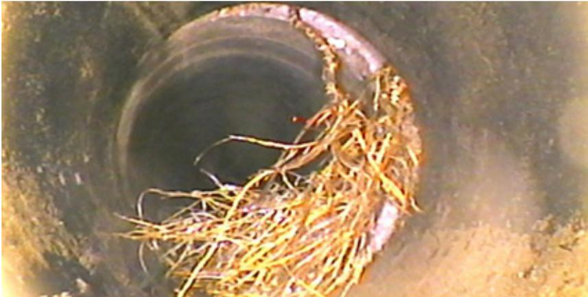
Abwasser kann aus schadhafte Anlagen- beziehungsweise Kanalteilen ausdringen (Exfiltration) und den Boden oder sogar das Grundwasser verunreinigen und damit das "Lebensmittel Trinkwasser" gefährden. Zudem besteht die Gefahr, dass unzureichend abgedichtete Kellerwände und Fußböden durchfeuchtet werden. Dabei kann es zu Schimmelbildung und einer dauerhaften Schädigung des Gebäudes kommen. Von den hygienischen Auswirkungen durch die Fäkalien ganz zu schweigen.
