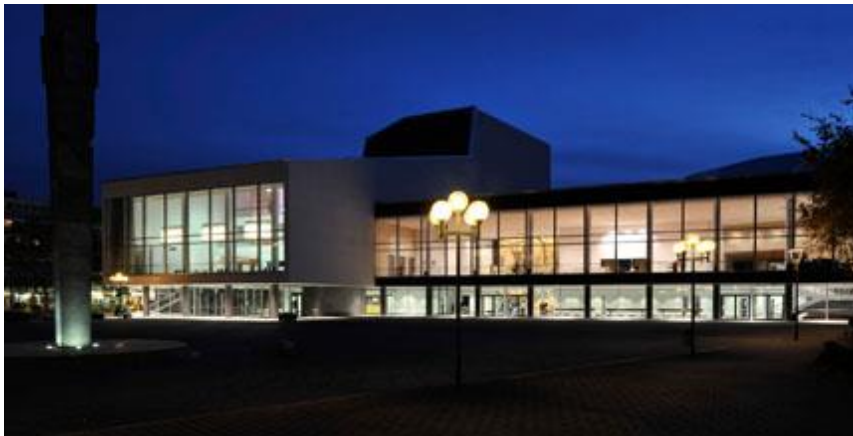
Das Theater und Kongresszentrum Pfalzbau
