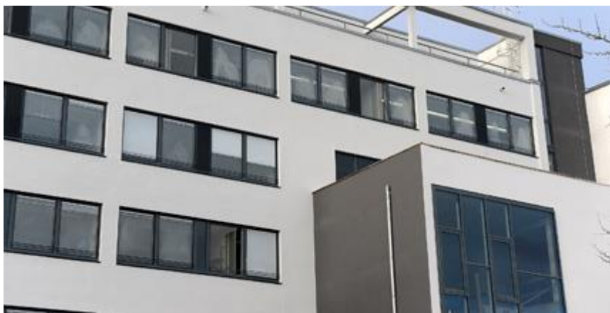
Energetisch sanierte Fassade der Stadtbibliothek
